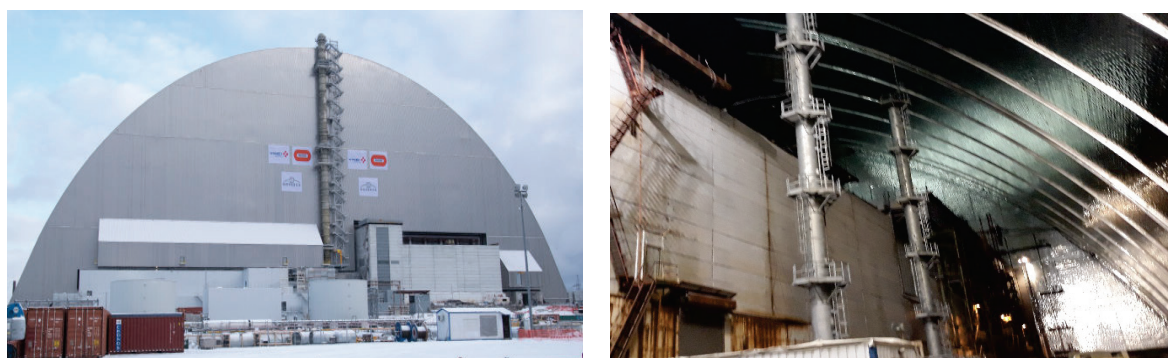
Рис. 2. Фото Арки із зовні та вишок для лафетних стволів подавання піни де а – лафетні вишки розташовані уздовж четвертого блоку ЧАЕС; б – пожежна насосна станція, яка забезпечує роботу лафетних вишок.
