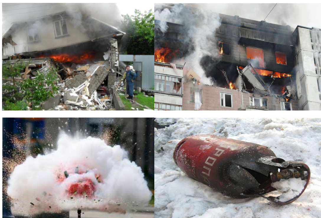
Рис. 1. Последствия взрыва систем хранения газа пропан-бутан
