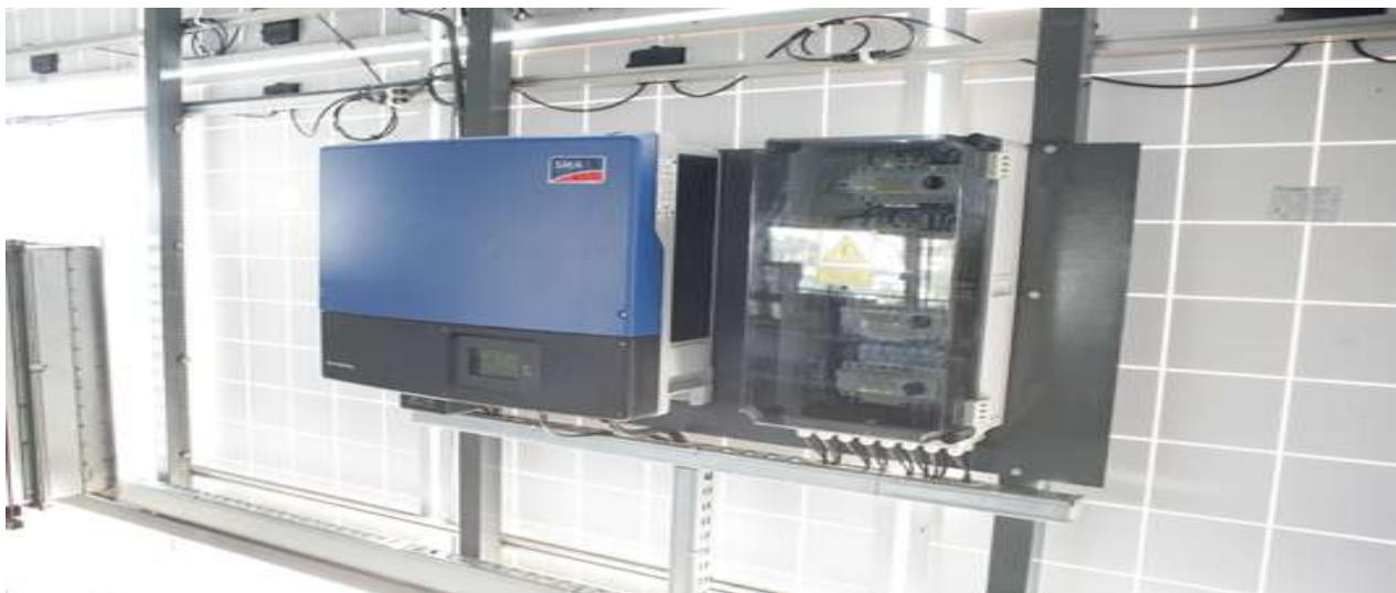
Інвертор (зліва) та коробка запобіжників постійного струму (праворуч)
