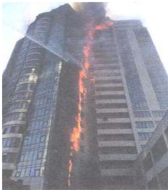
Рис. 2. Поширення полум'я по конструкціям фасаду житлового будинку
