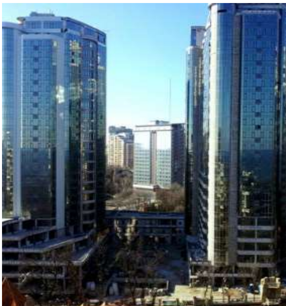
Рис. 1. Вигляд житлового комплексу до пожежі
