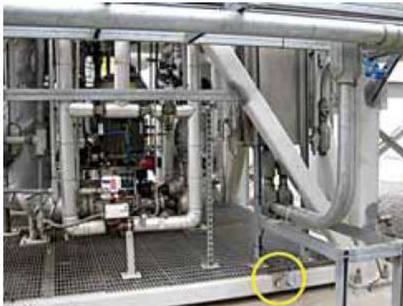
Рисунок 1 – Закріплений п'єзодатчик вібрації Volture на коливній платформі [1]
