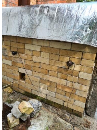
Рис. 2. Вигляд малогабаритної вогневої печі підготовленої до нагрівання фрагменту плити
