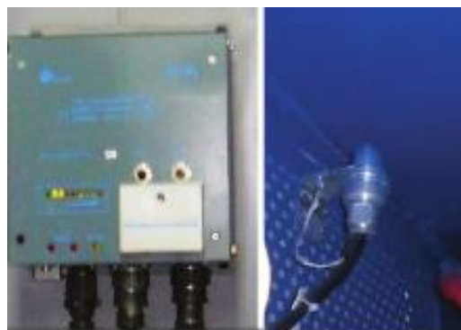
Рисунок 4 – Система газообнаружения компрессорных установок
