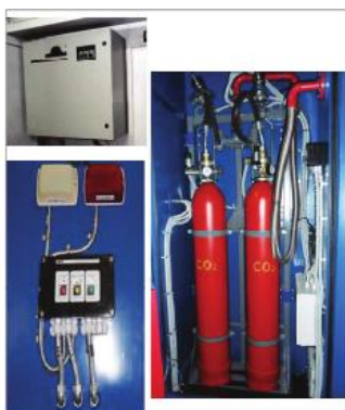
Рисунок 3 – Система противопожарной защиты компрессорных установок
