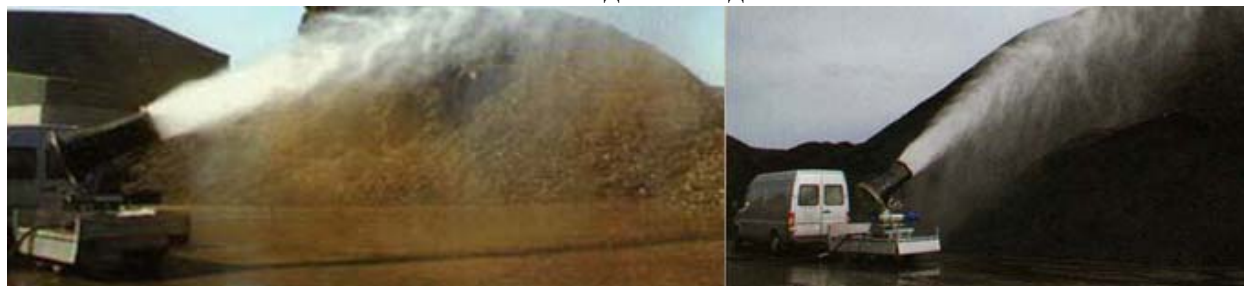
Рис. 1.2 – Создание водяной завесы компактной струей воды при помощи брандспойта
