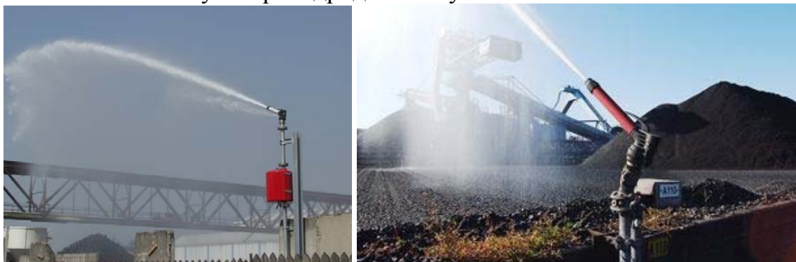
Рис. 1.1 – Создание водяной завесы
