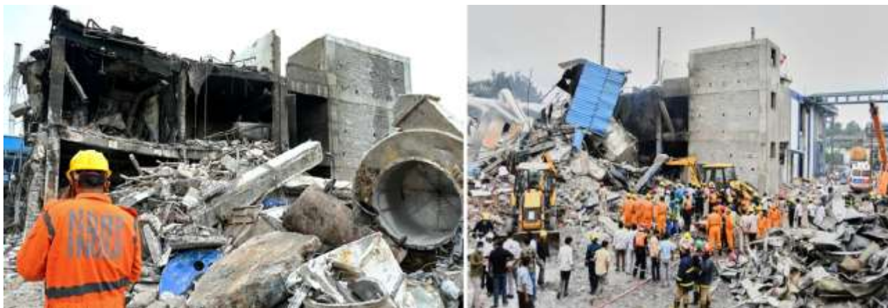
Рисунок 1.10 – Руйнування виробничої будівлі внаслідок вибуху та пожежі
