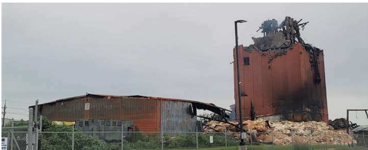
Рисунок 1.11 – Наслідки пожежі та вибуху у будівлі млина
