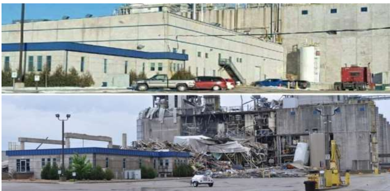
Рисунок 1.9 – Наслідки пожежі та вибуху у будівлі млина
