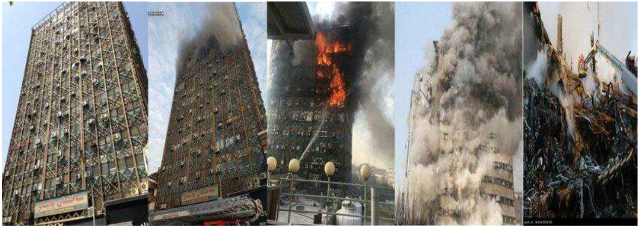
Рисунок 1.4 – Наслідки пожежі у будівлі PLASCO. 2016, Тегеран
