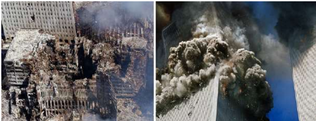
Рисунок 1.3 – Руйнування світових торгівельних центрів внаслідок терористичного акту та ефекту прогресуючого обвалення, 2001, США
