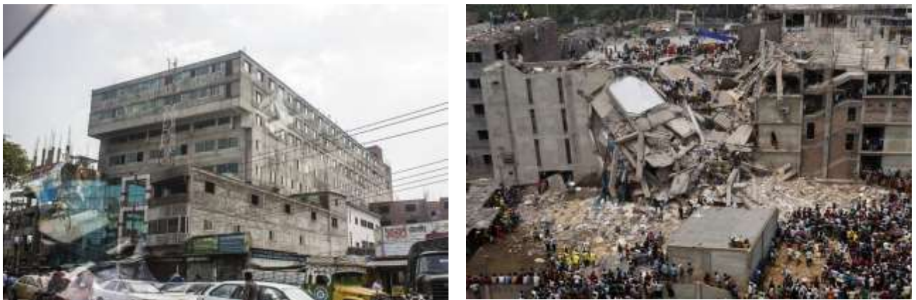
Рисунок 1.7 – Обвалення будівлі Rana Plaza, Савар 2013, Індія
