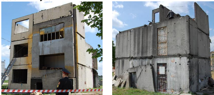
Рис. 3. Зовнішній вигляд триповерхової нежитлової будівлі, що вийшла з експлуатації, для улаштування моделі приміщення із пожежею
