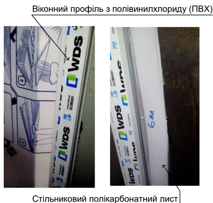
Рис. 2.4. Зовнішній вигляд елемента скління досліджуваної системи легкоскидних конструкцій
