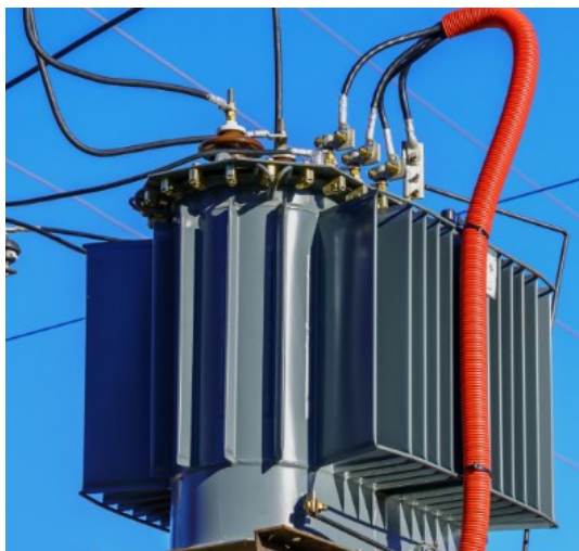
Рисунок 1.7 – Приклад під'єднання кабелю до маслонаповненого трансформатора
