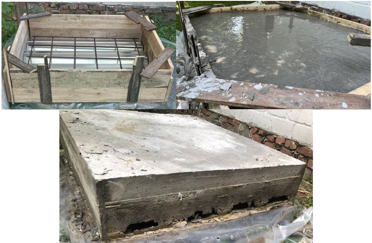
Рисунок 3.1. Процес виготовлення фрагментів сталезалізобетонної плити
