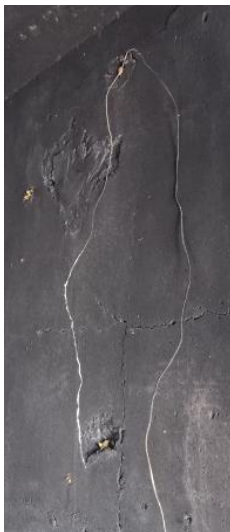
Рисунок 4.4 – Фото місця розташування термопар у споруді ВБ-40
