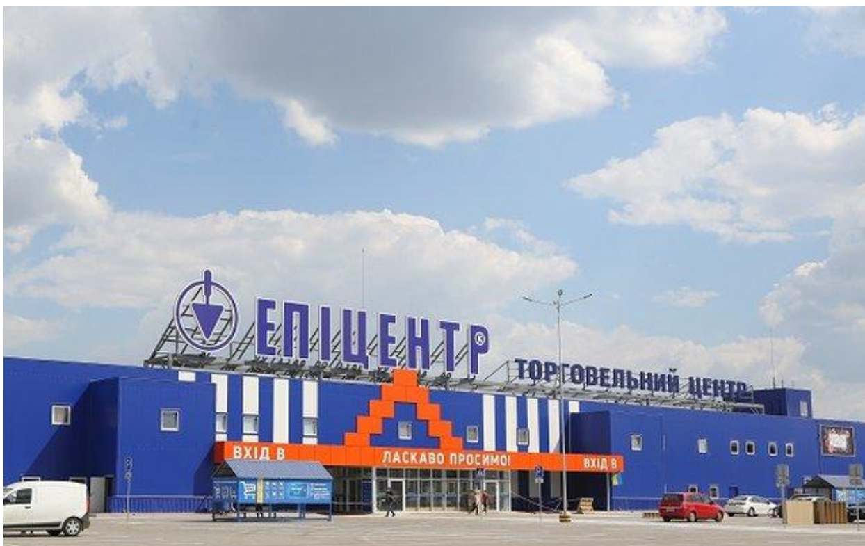
Рисунок 3.4 – Зображення будівлі Епіцентру до пожежі
