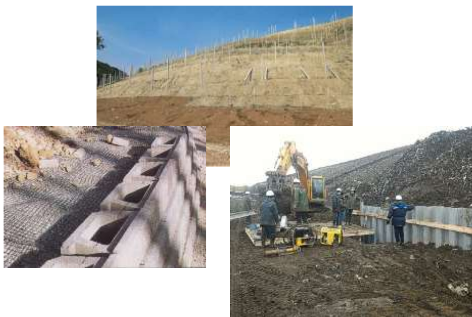
Рисунок 2.11. Влаштування протизсувних, утримуючих конструкцій.
