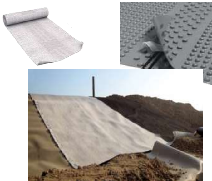
Рисунок 2.10. Покриття геосинтетичними рулонними матеріалами.
