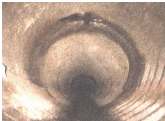
Рисунок 2.3 – Процес телеінспекції трубопроводу
