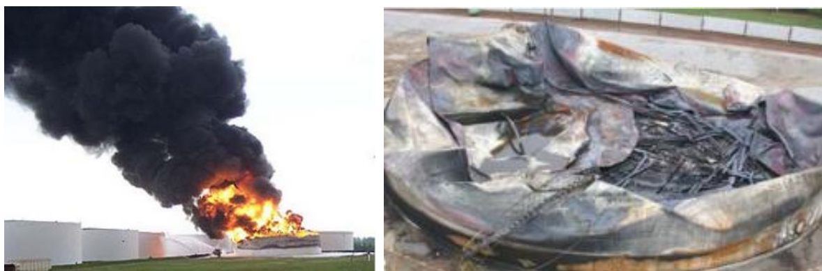
Рис. 1.1 - Пожежа в 2007 році на резервуарі з плаваючою дахом (США)
